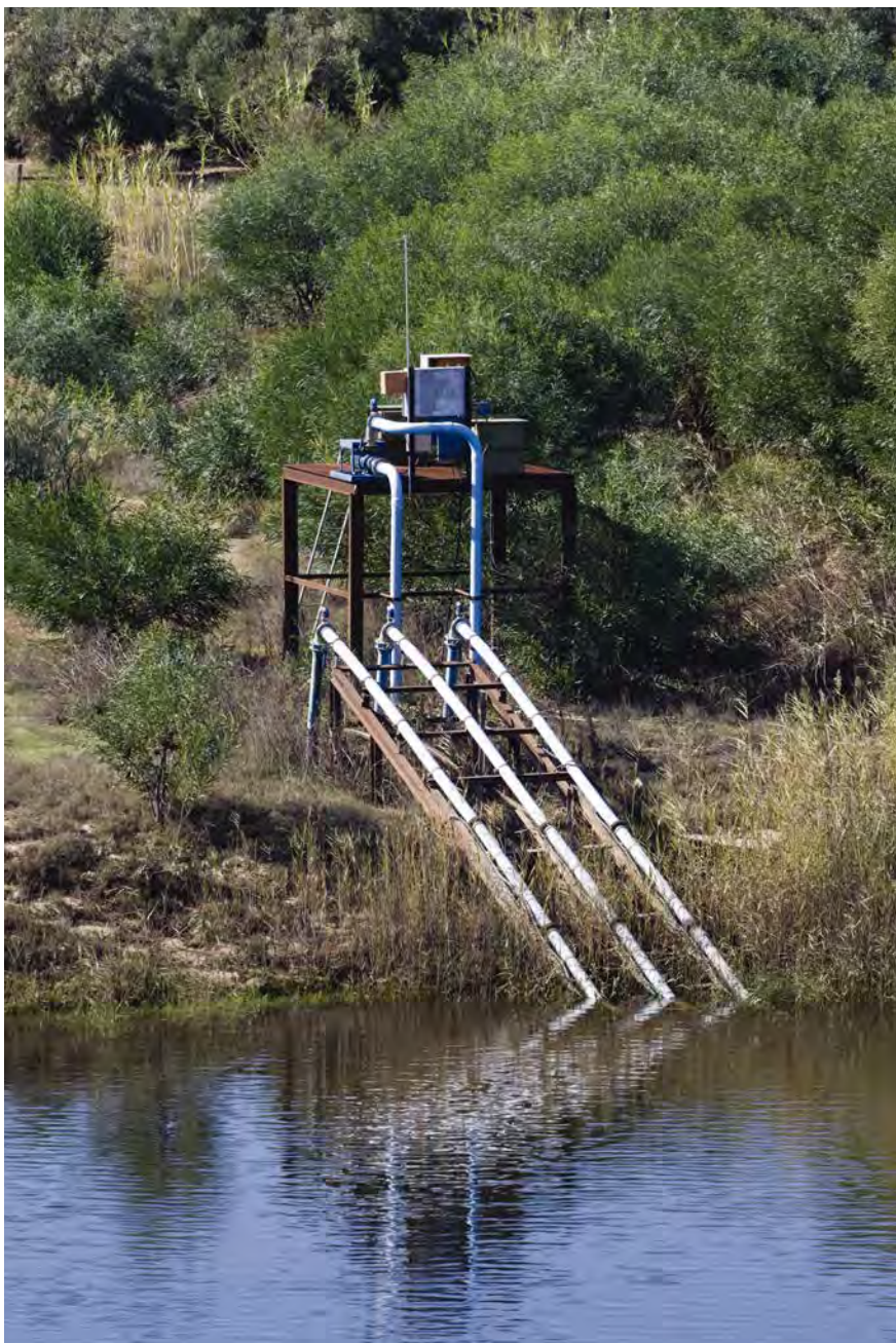
Bombas eléctricas para sacar agua del río Breede en la provincia del Cabo Occidental de Sudáfrica para el riego de tierras áridas al lado del río. Foto: Abraham Badenhorst / Shutterstock
