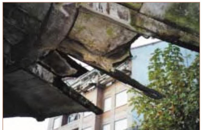
Foto 6. En esta fotografía, se pueden observar los severos daños producidos por la carbonatación sobre algunas varillas.
