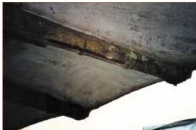
Foto 11. Otra vista de una de las varillas –que conserva intactas las bovedillas de su cobertura– atacada por la carbonatación. Se puede observar la oxidación en la armadura longitudinal y transversal al descubierto.
