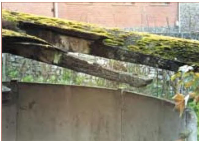
Foto 10. Disgregación de la masa de hormigón en las varillas de la cobertura, debido a una carbonatación severa.
