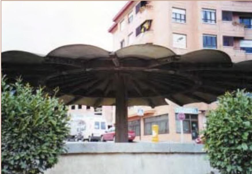
Foto 4. Otra vista del lavadero de la Corredoria; con anterioridad a su rehabilitación, el mástil llegó a estar sujeto únicamente por las armaduras longitudinales del mismo. Esta foto de la estructura portante del paraguas, da idea por sí sola del excelente trabajo realizado.
