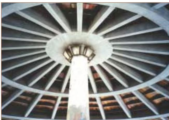
Foto 2. Entramado de la estructura portante, formado por dos vigas riostras circulares y las varillas que irradian desde la coronación del fuste.
