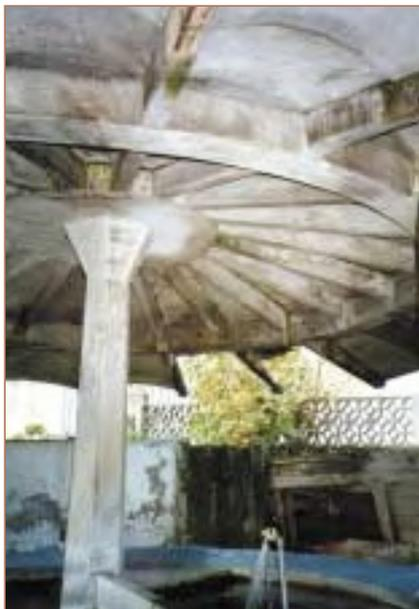
Foto 9. Tanto la viga riostra, como las varillas centrales (que enlazan el capitel con la viga citada), se encuentran libres de carbonatación.
