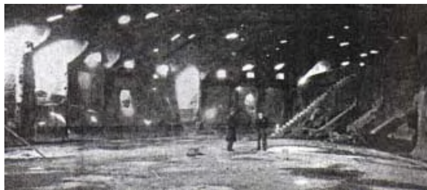
Esta imagen -a pesar de su mala calidad-, da muestra suficiente, de los daños sufridos durante la Guerra Civil.
