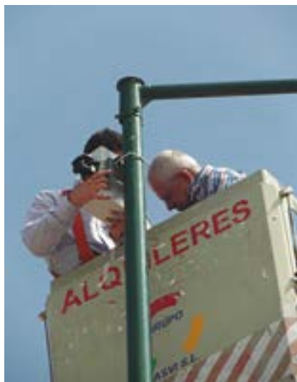
Instalación de uno de los sensores, en concreto del nodo láser, durante las pruebas. Foto: F. Descubre.
